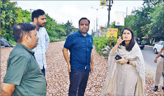
करनाल। आउटर बाईपास सड़क निर्माण कार्य का निरीक्षण करती नगर निगम आयुक्त सलोनी शर्मा।
